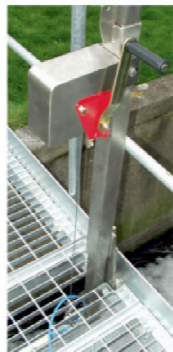
Pakėlimo mechanizmas, jei reikia atlikti apžiūrą arba pakeisti jutiklį nenutraukiant veikimo
