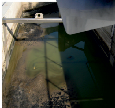
Pakėlimo mechanizmas, jei reikia atlikti apžiūrą arba pakeisti jutiklį nenutraukiant veikimo
