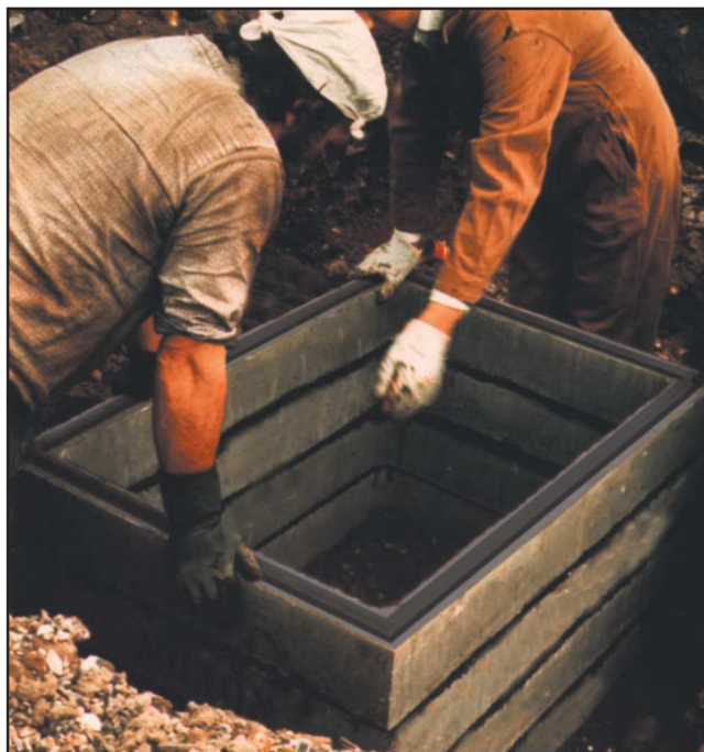
Viršutinis gelžbetonio šulinio elementas dedamas ant Densostrip sandarinimo juostos.
