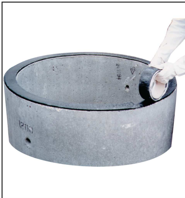
Densostrip juostos klijavimas ant gruntuoto paviršiaus.
