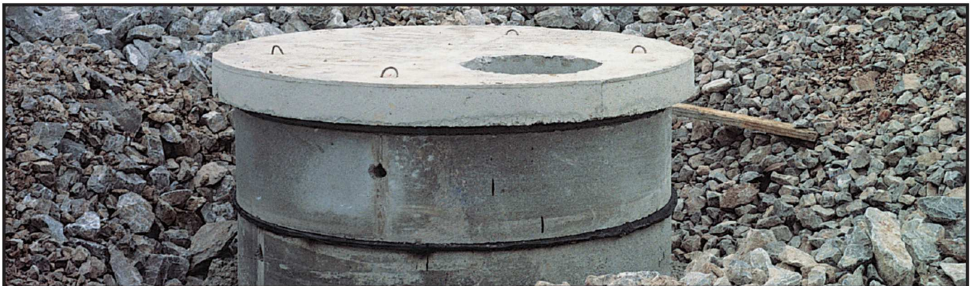
Gelžbetoninis šulinys sumontuotas naudojant Densostrip sandarinimo technologiją.
