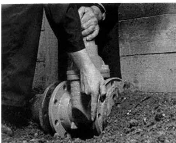
Užmauname flanšus 0102 ir įstatome į vietą
